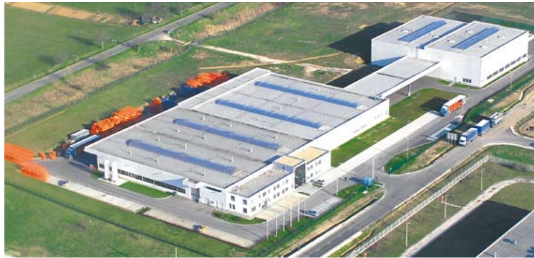
Erweiterung der Produktionsfläche bei KIRCHHOFF Automotive Ungarn: links im Bild der Neubau
