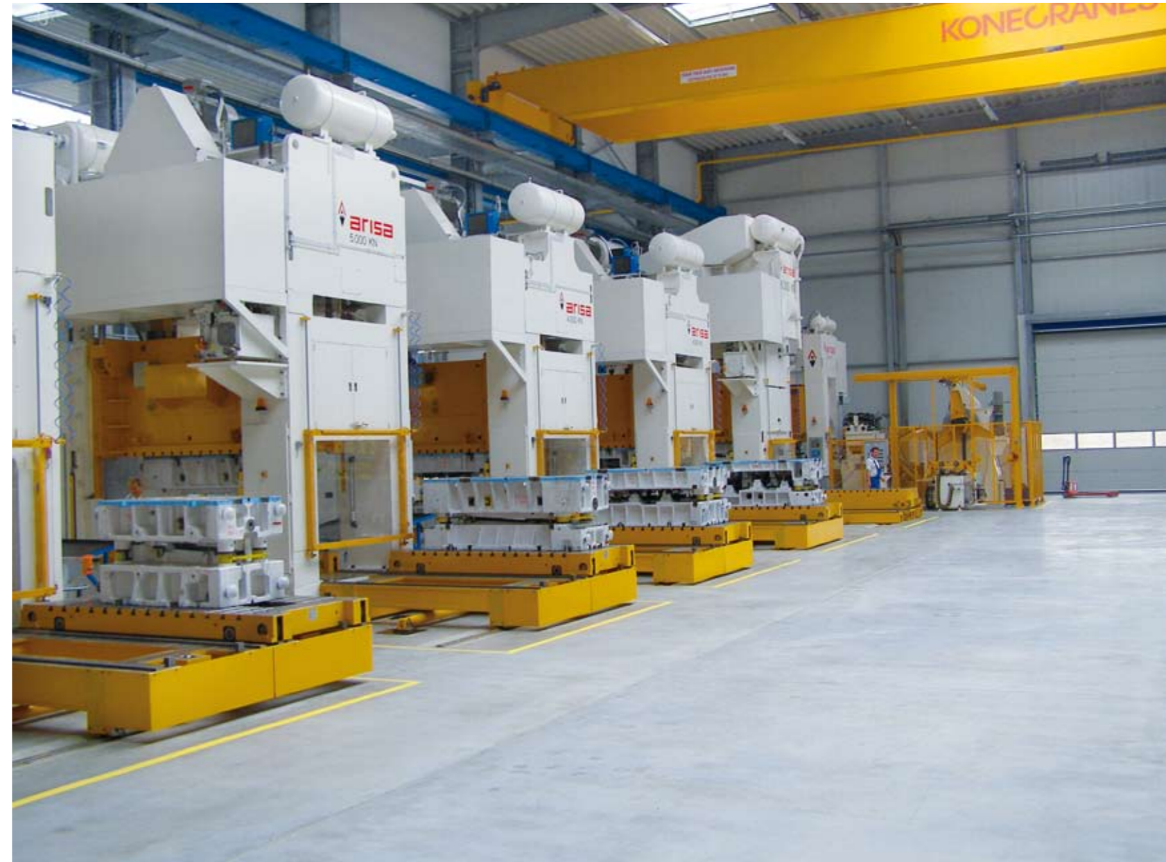
Die neu installierte Pressenstraße mit Pressen bis zu 650 t
